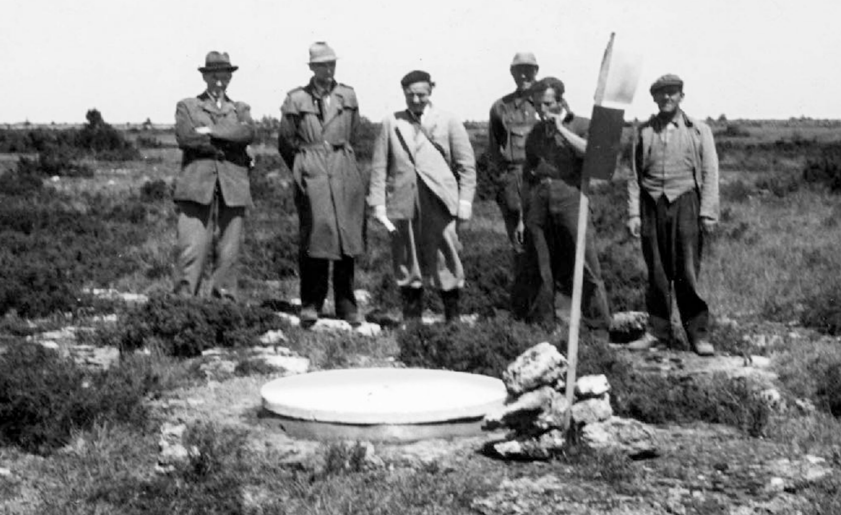
Fältet förlades till Öland. Punkterna i metoden kom att utgöras av järnrör, i betonglock för att kunna upptäckas på flygbilderna. Första locket inspekteras här av Kalmars länsantikvarie Hofrén, i mitten. Hallert till vänster, och till höger tre män från Stora Rørs cementindustri med ägaren Gösta Jansson längst ut. Sjätte personen kan vara riksantikvariern. (Foto G Jansson)
