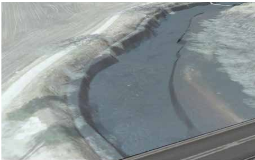
Lodning av åbotten inför tryckning av ledning under ån.
