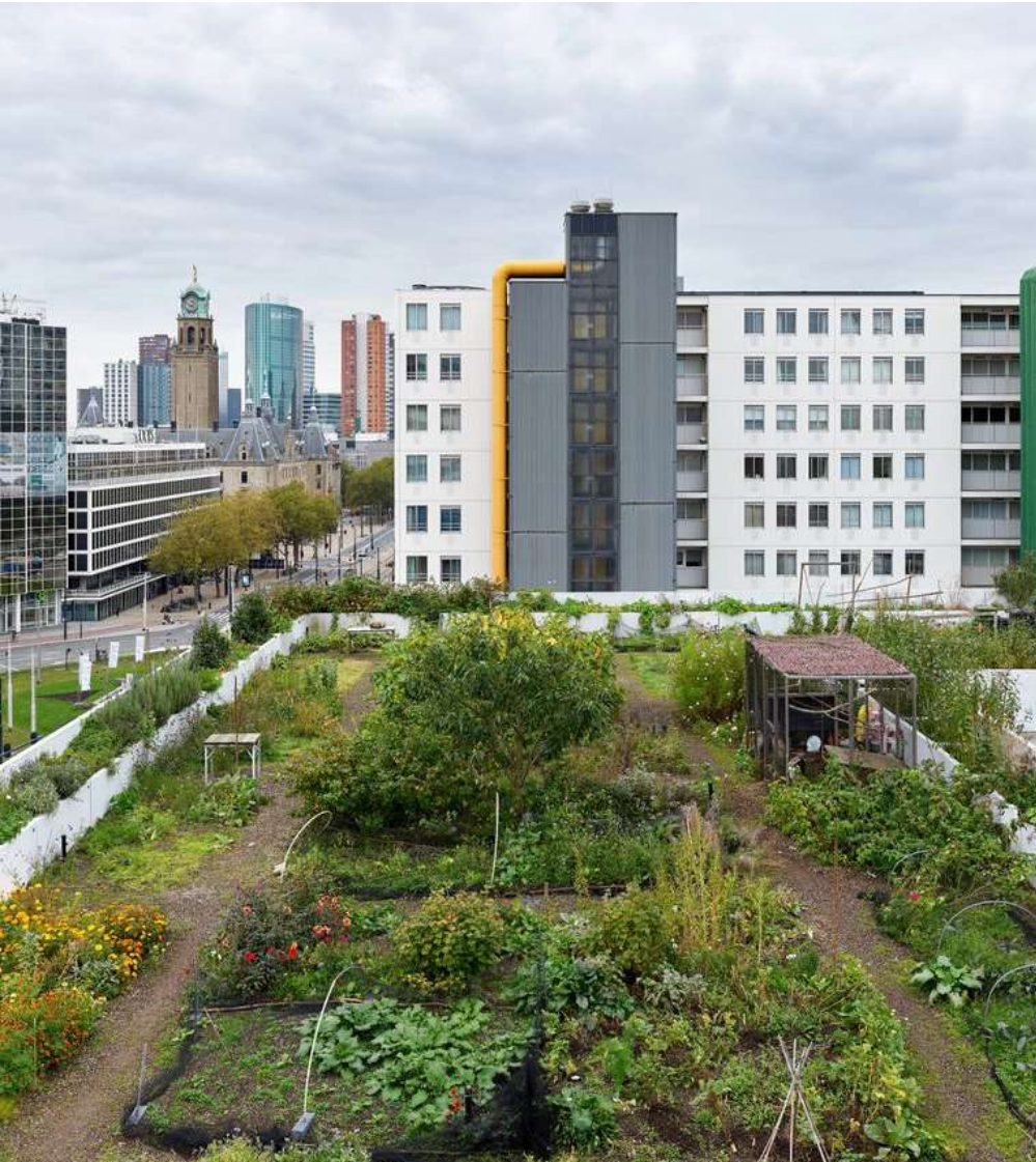
Dakkackers Roofgarden, Rotterdam NRC, 2021. Het is de hoogste tijd voor meer dakkackers in de steden. https://www.nrc.nl/nieuws/2021/10/28/het-is-de-hoogste-tijd-voor-meer-dakkackers-in-de-steden-a4063308
