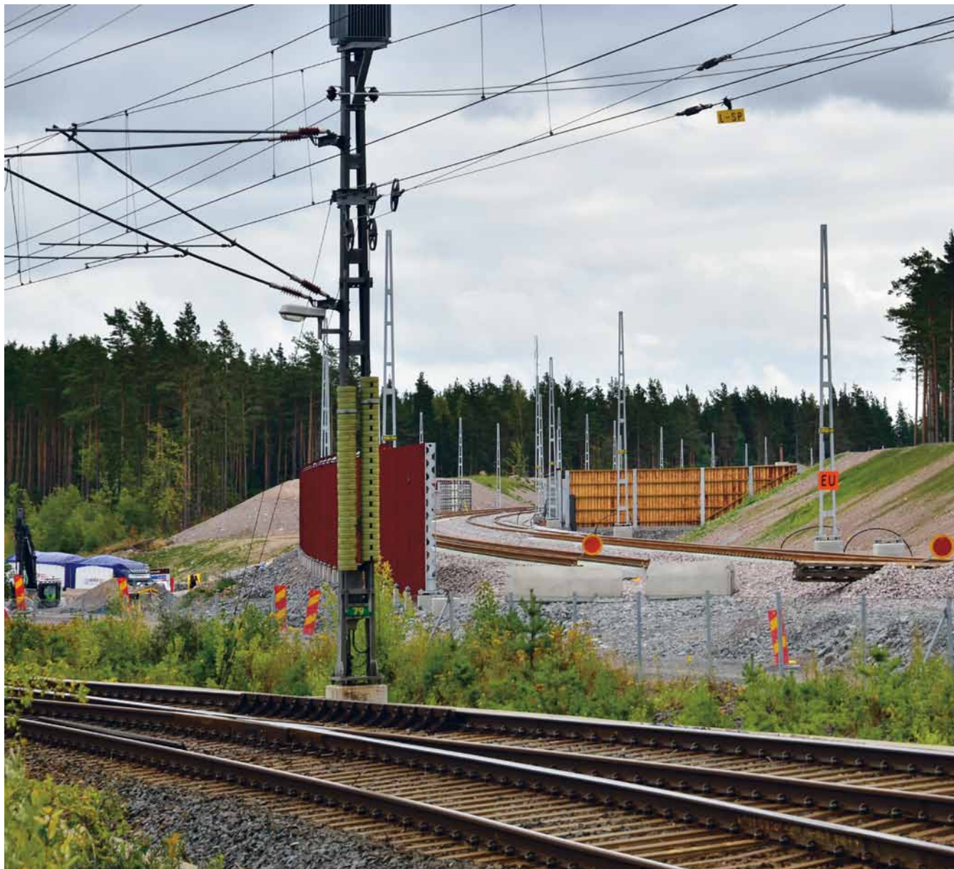
Utbyggnad av dubbelspår mellan Furuвик och Skutskär. Foto: Göran Malm
