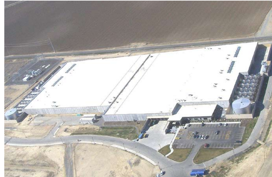
Gigantiska anläggningar – stora som flera fotbollsplaner – för drift av tiotusentals servrar. På bilden Microsoft Data center i Quincy, Washington.
