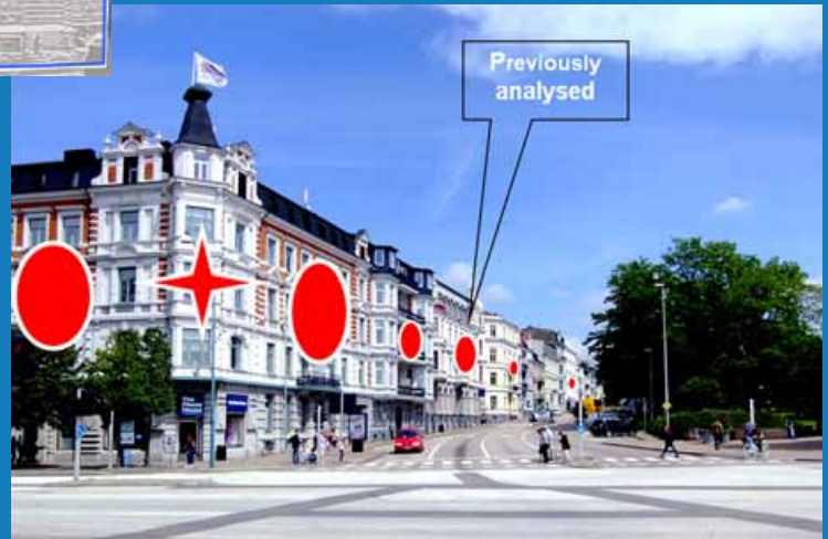
Figur 10 Den överförda fasadbilden sammankopplas med andra fasader
