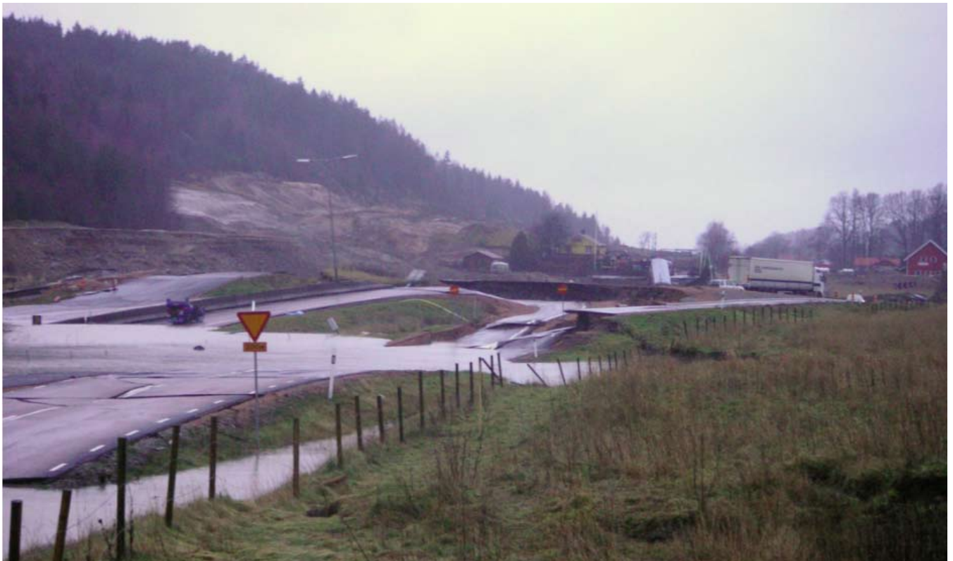
Bra höjddata, tillsammans med annan information om t.ex. jordarter etc, är en förutsättning för att minimera risken för ras och skred. Bilden visar vägras på E6 i Bohuslän 2006. Foto: Räddningsverket/Myndigheten för samhällsskydd och beredskap.
